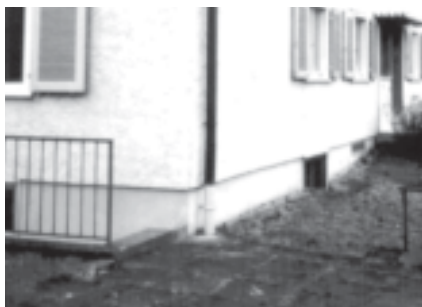
Fassadenanschlüsse: unten verbessert zur Austrocknung
